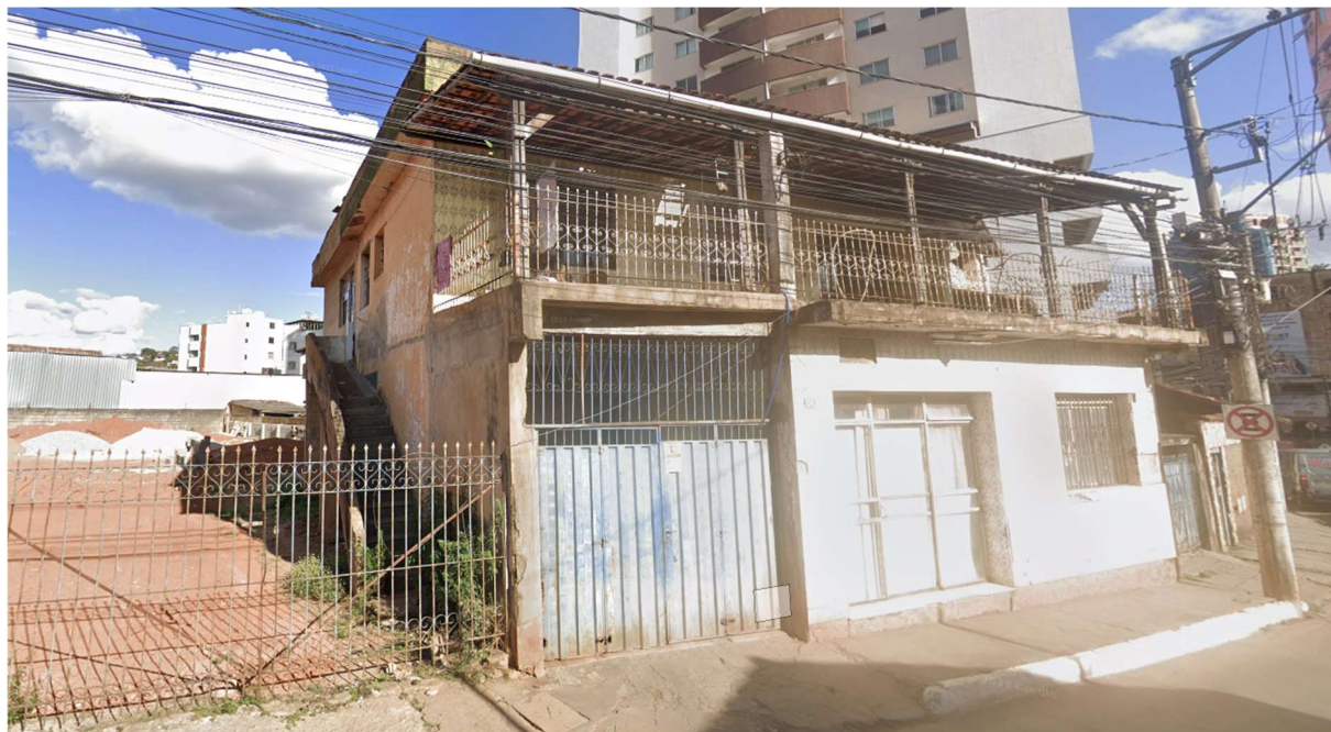
ANEXO FOTOGRÁFICO – IMÓVEL A SER DEMOLIDO
