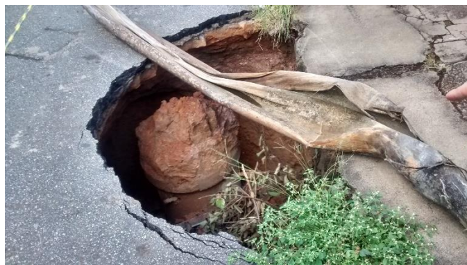
REPARO EM REDE PLUVIAL
