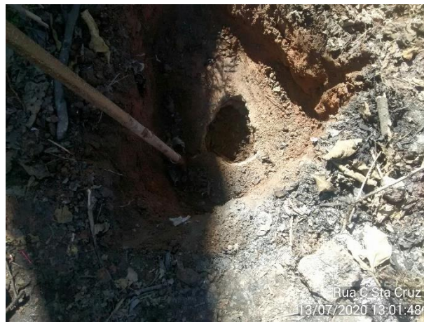
REPARO EM REDE PLUVIAL
