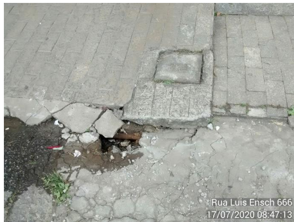
REPARO EM REDE DE ESGOTO
