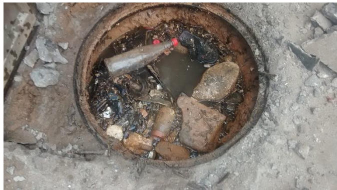
TROCA DE TAMPÃO E MANUTENÇÃO EM POÇO DE VISITA
