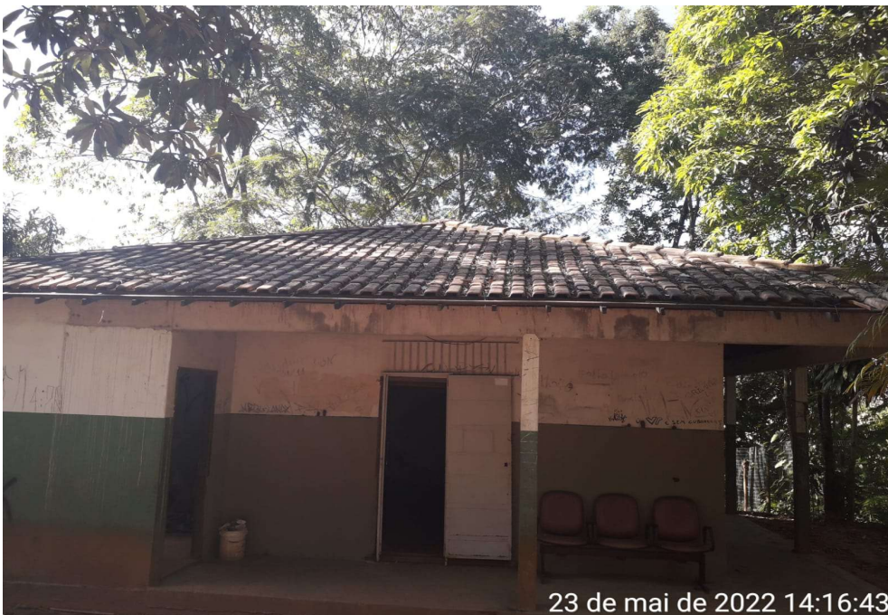
FIGURA 6 – FOTO PARTE INTERNA (COZINHA)
