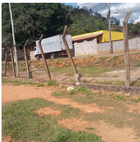
Figuar 5 - Mourões com blocos de concreto na base.
